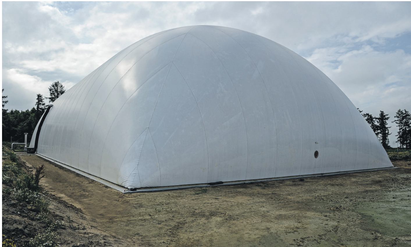
Speicher sind notwendig: Dank eines großen Gasspeichers von 18000 Kubikmetern können die Motoren bis zu 60 Stunden ruhen.
