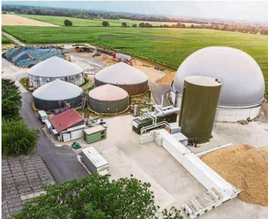
Blick auf den Hof Rohlf's in Strange 47 mit einem Teil der jetzt flexiblen Biogasanlage.
